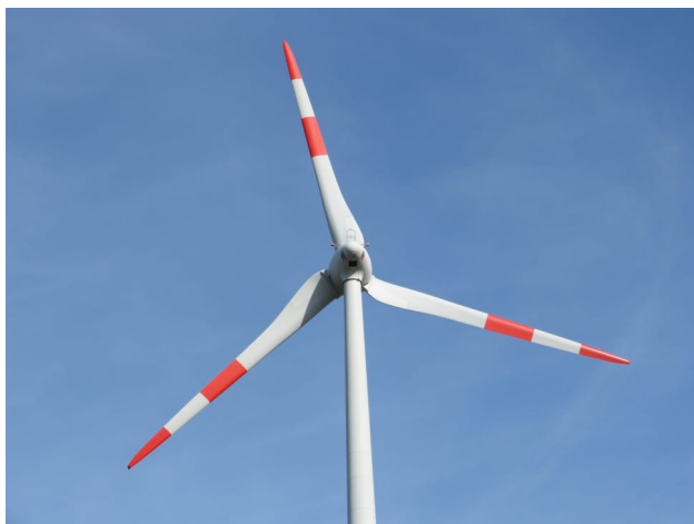
Figuur 13: Verbeterde zichtbaarheid turbines door rode vlakken op turbinebladen
